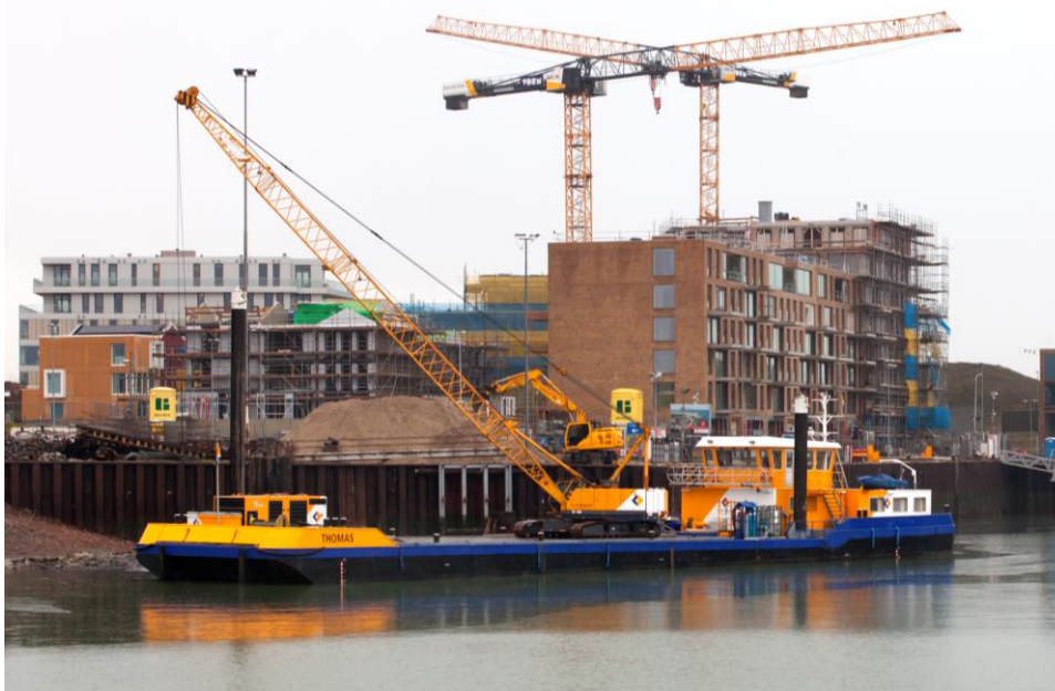
Figuur 2: Plaatsen van de damwandconstructie
