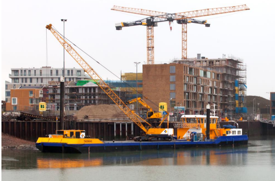
Figuur 2: Plaatsen van de damwandconstructie
